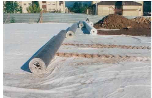
Fig. 15: Extensión de bentonita sobre geotextil
